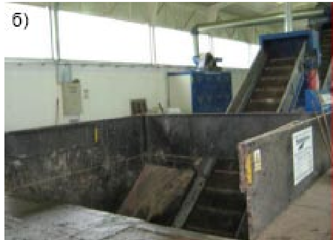
Слика 10 - Транспортна трака која одводи отпад из прихватне коморе
