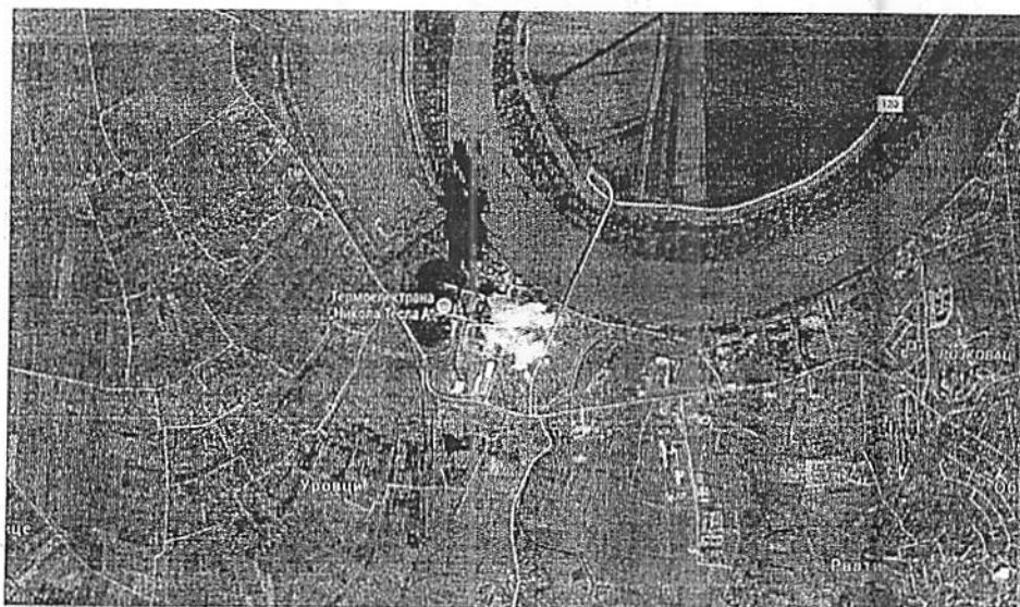
Слика бр. 45: Локација ТЕНТ А Извор: Google maps
